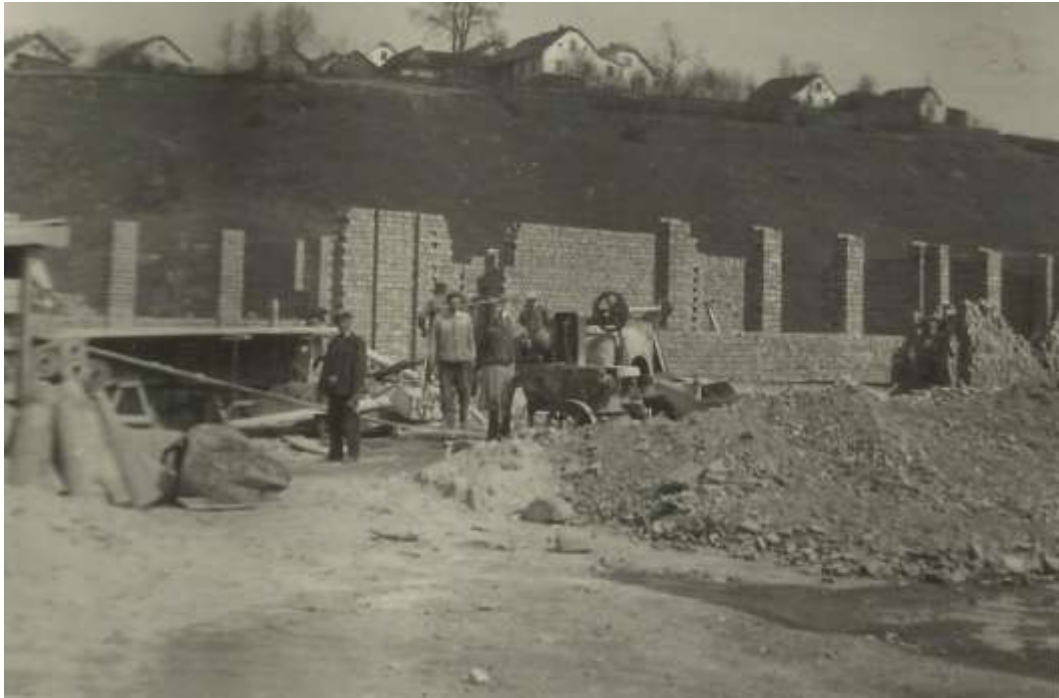
Pracovné nasadenie pri stavbe 2. pavilónu školy
